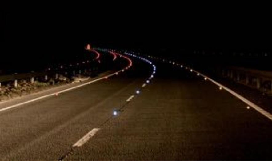
Las **tachas reflectivas Incapeca** son elementos de alto desempeño y durabilidad, resistentes a la abrasión, y de alta calidad reflectiva, características que garantizan la visibilidad y delineación efectiva de la ruta, esto siempre y cuando la tacha siga adherida al pavimento. Es vital seleccionar el adhesivo correcto según la superficie de la vía..
